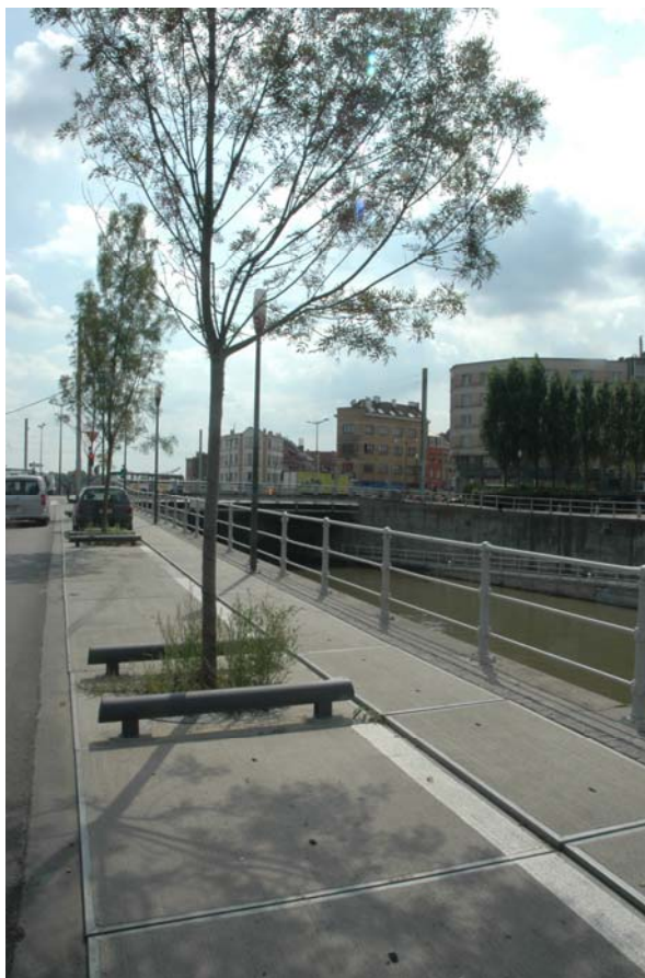
Anderlecht, rives du Canal Grandes dalles béton et acier
