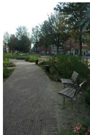
Anderlecht Square Jean Rey, Pavés de terre cuite et dolomie
