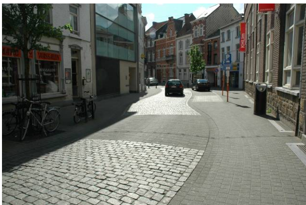
Hasselt : voirie mixte pavés naturels / pavés béton.
