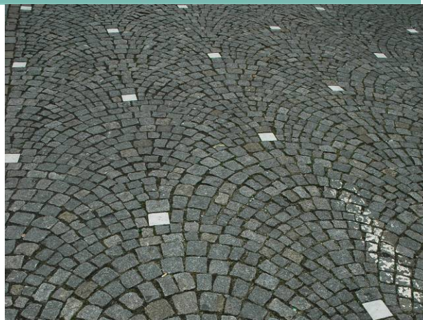
Bruxelles, Rue de la Reine - pavés mosaïques
