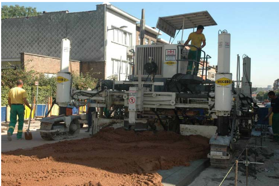
Ganshoren : mise en place mécanique d'un béton coulé coloré
