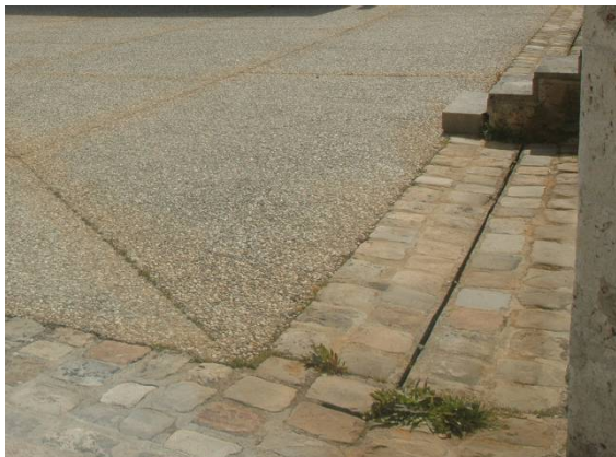
Artenay (Fr.) – jeu de matières et de couleurs Béton lavé à granulats ronds et pavés de pierre naturelle
