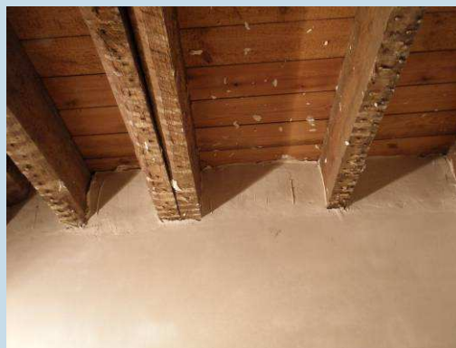
Bonne mise en œuvre du plafonnage entre gîtes (Source : Bruxelles Environnement - IBGE)
