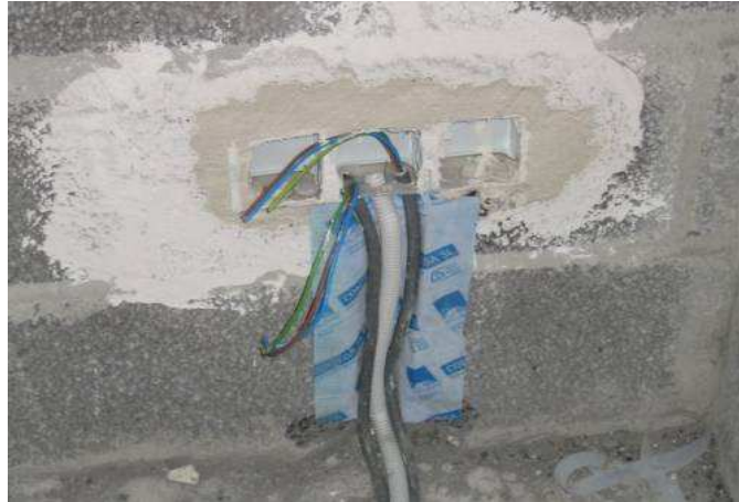
Étanchéité du blochet (Source : André Baivier)
