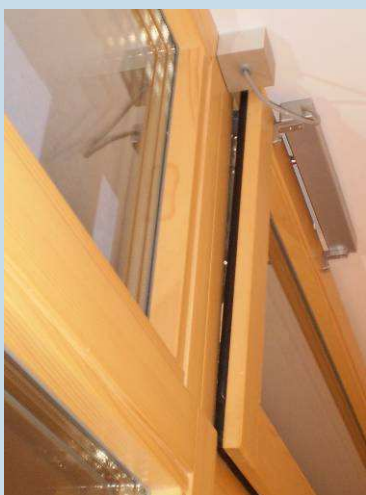
Mauvais réglage de la motorisation des fenêtres (Source : Matriciel)
