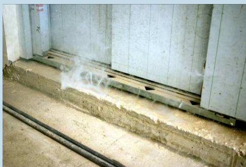
Infiltratietest met rookinstallatie onderaan de liftkooi (Bron: Matriciel)
