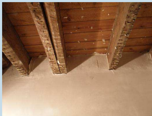
Correcte uitvoering van de plafonnering tussen de zolderbalken (Bron: Leefmilieu Brussel - BIM)
