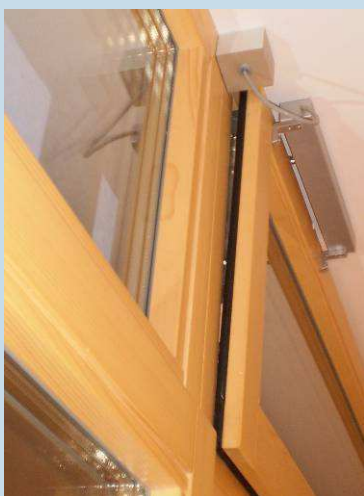
Slechte regeling van de motorisering van de vensters (Bron: Matriciel)
