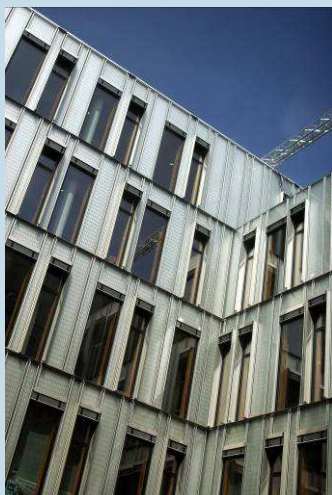
Façade intérieure du bâtiment AEROPOLIS II (Source Matriciel)
