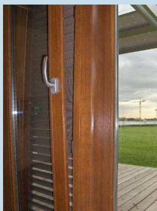
Grille derrière fenêtre dans un bureau (Source : Caméléon)
