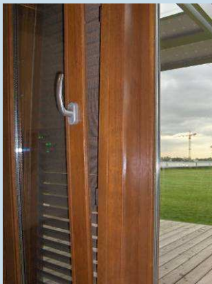
Ouvertures manuelles des bureaux
