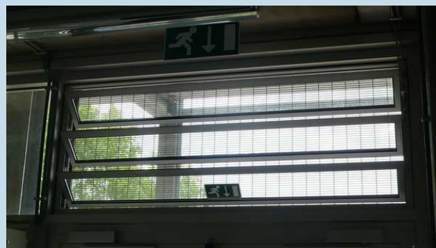
Ouvertures motorisées et grillagées des salles de vente
