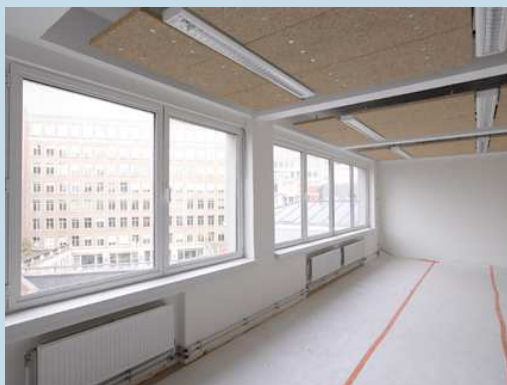
Voorbeeld van gedeeltelijk verlaagde plafonds (Bron: Leefmilieu Brussel - BIM)
