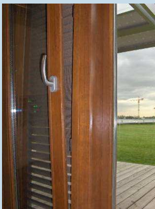
Manuele openingen van de kantoren
