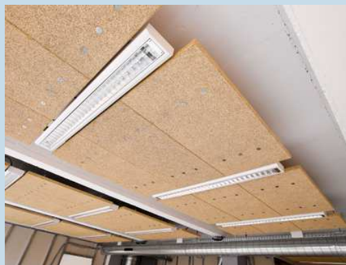
Voorbeeld van gedeeltelijk verlaagde plafonds (Bron: Leefmilieu Brussel - BIM)
