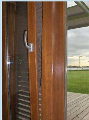
Rooster achter venster in een kantoor (Bron: Cameleon)
