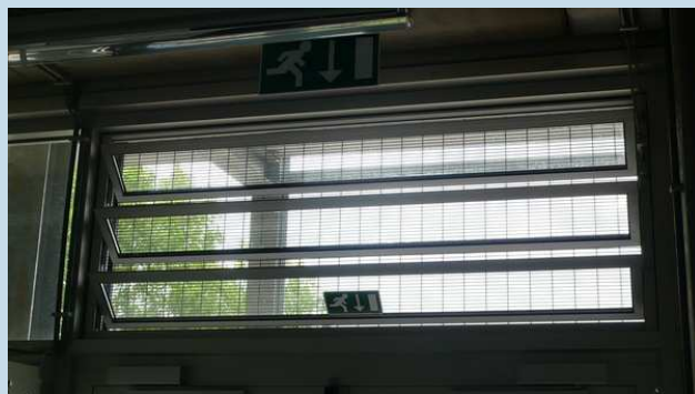
Gemotoriseerde en afgerasterde openingen van de verkoopzalen
