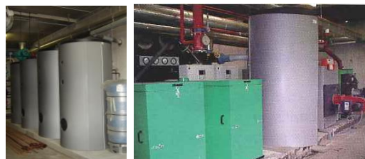
opslagvaten zonnestelsel (foto links) en 2 WKK-eenheden condensatieketel (foto rechts)
