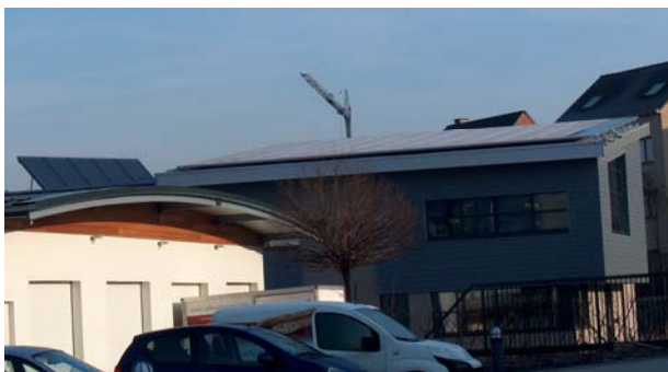
1500 m 2 de surface au sol utilisable
