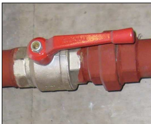
Figure 5.57: vanne à boisseau sphérique
