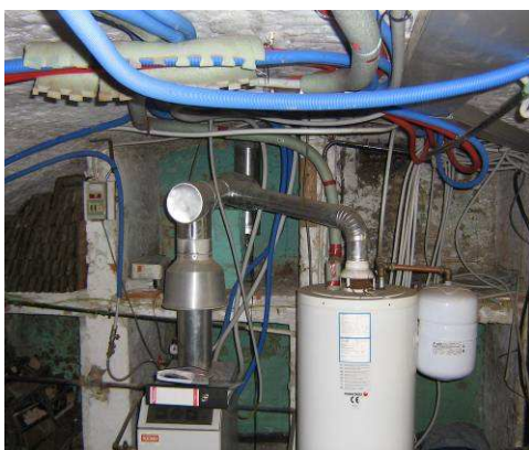
Figure 1.6: vieille chaudière → NO x = 7 kg/an → réduction d'émission de 80%.
