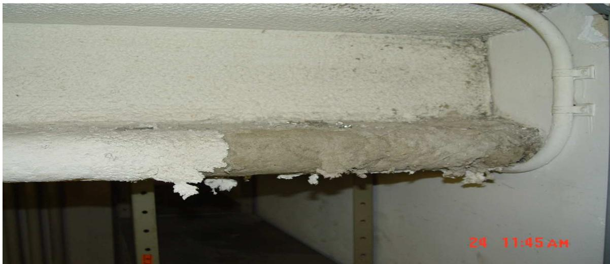
**Figure 4.3.3: Flocage (60 à 80% d'amiante)**
