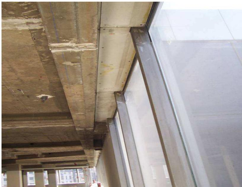
**Figure 4.3.5: Plaques de type « Pical » (Plafonds, cloisons, clapets, bardage de gaines,...)**
