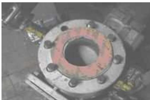
**Figure 4.3.6: Joint amianté de type «klingerite » entre les brides de conduites de chauffage**
