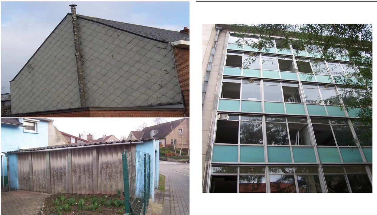
**Figure 4.3.8: Amiante-ciment, plaques de type « Glasal » (allèges, cloisons, faux-plafond, protection murale...)**
