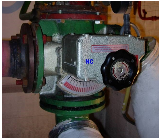
Afbeelding 3.22: gemotoriseerde 3-wegklep
