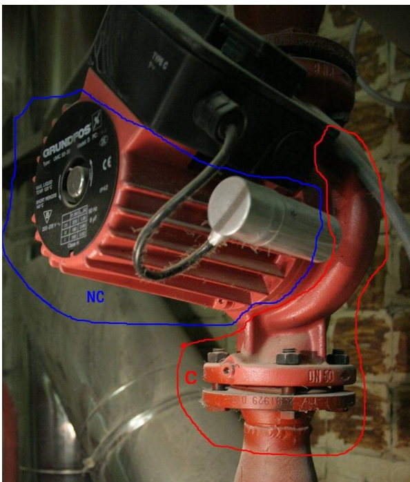
Afbeeldingen 3.21: delen van een circulatiepomp en van een pomp die al dan niet thermisch geïsoleerd moeten worden.
