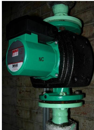
Afbeelding 3.20: voorgevormde isolatieschaal voor het circulatiepomphuis
