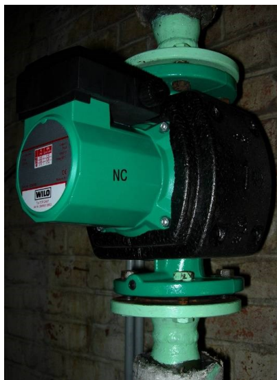
Afbeelding 3.20: voorgestemde isolatieschaal voor het circulatiepomphuis
