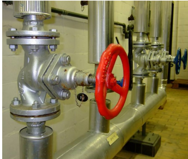
Afbeelding 3.8: isolatiekranen, voorzien van een klep met rechte zitting
