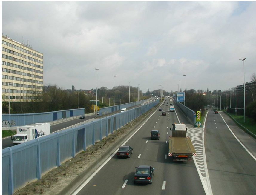
Figure 1 - vue depuis le pont de l'avenue d'Itterbeek, vers le nord, visualisation des sortie 14A
