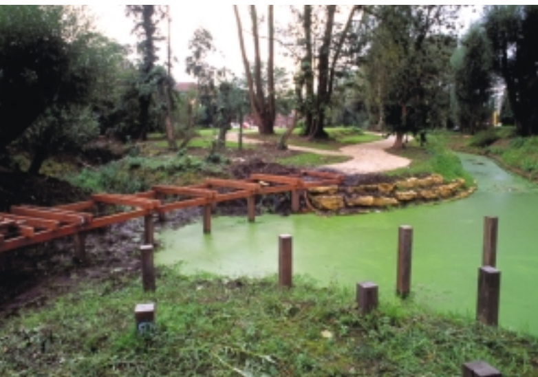
Aanleg van de Woluwe
