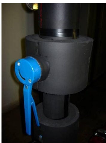
Figure 8.4 – Calorifugeage d'accessoires
