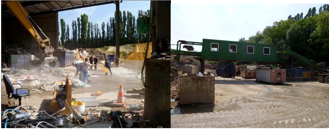
Illustration 57 : Tri manuel et aidé d'une pelle hydraulique sous hangar et vue de la cabine de tri, utilisée occasionnellement. Les inertes triés sont jetés directement dans les containers adéquats situés sous la cabine
