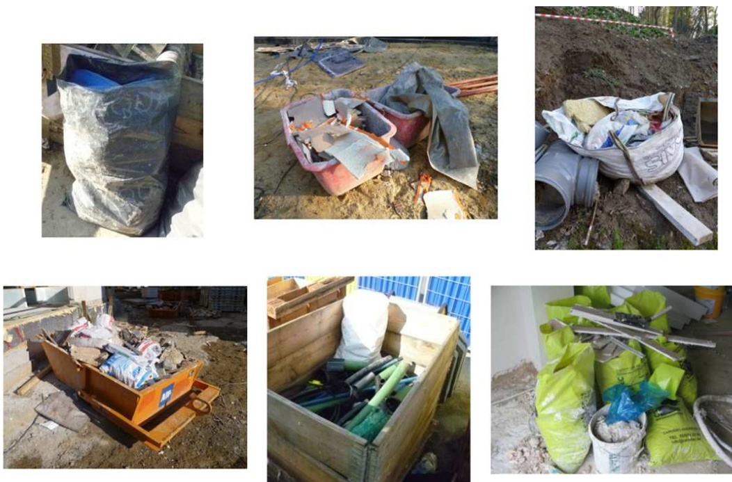
Illustration 22 : exemples de contenants provisoires utilisés sur les chantiers
