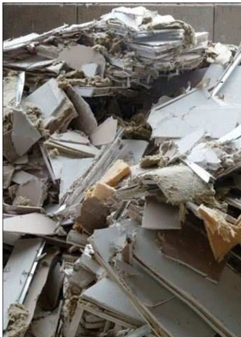
Illustration 52 : Le tri manuel permet de séparer les différentes matières constituant des parois de bureaux en plâtre
