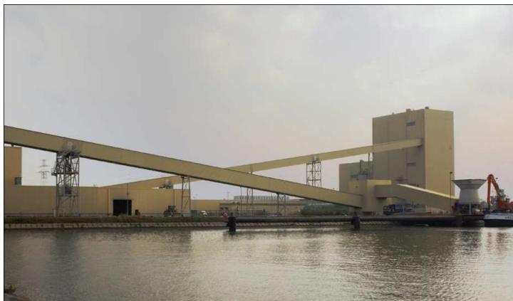
Illustration 48 : Photo de l'usine (source : Gyproc)
