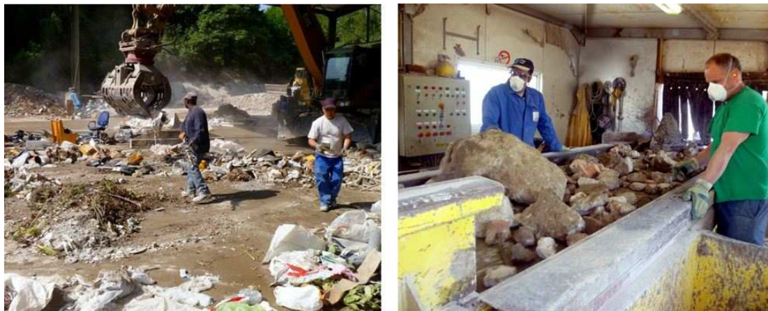
Illustration 96 : Tri manuel au sol, aidé par les pelles hydrauliques; tri à la ligne en cabine
