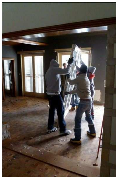
Illustration 76 :A) Démontage "à l'amiable" de radiateurs dans un chantier de démolition – B) Démontage "à l'amiable" de châssis dans un chantier de démolition
