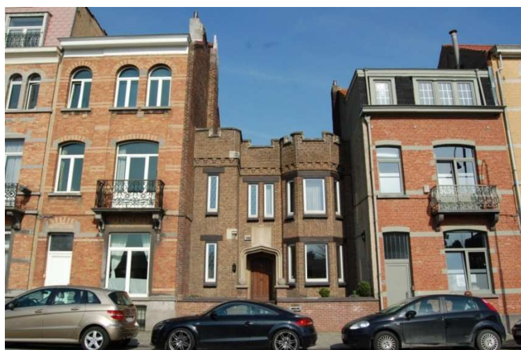
Illustration 27 : Chantier 14h : Rénovation d'une maison mitoyenne à Forest
