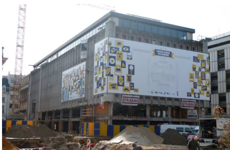
Illustration 29 : Chantier 40b : Transformation lourde d'un immeuble à Bruxelles (Muntpunt)
