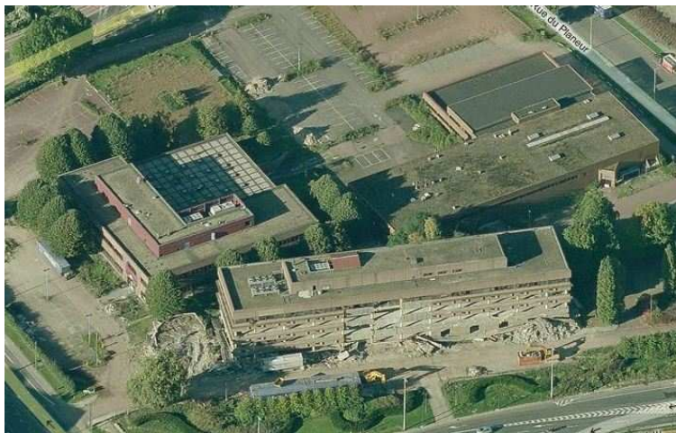
Illustration 28 : Chantier 33b : Démolition de 3 bâtiments d'un zoning industriel à Evere
