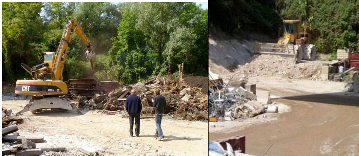
Illustration 56 : Broyage des déchets verts et Compactage des inertes au moyen d'un rouleau compresseur
