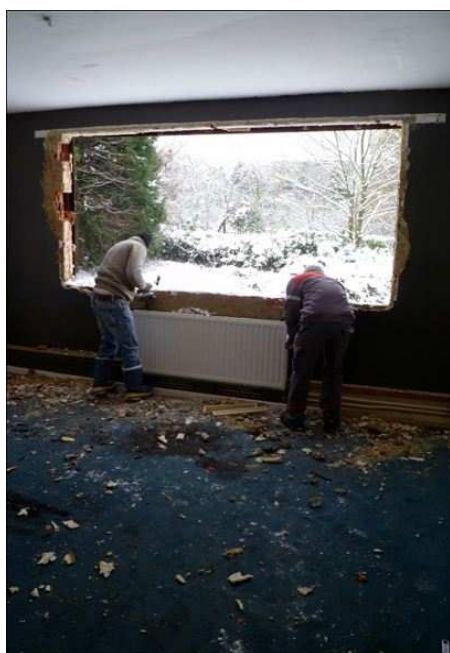
Illustration 76 :A) Démontage "à l'amiable" de radiateurs dans un chantier de démolition – B) Démontage "à l'amiable" de châssis dans un chantier de démolition
