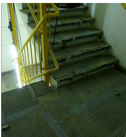
Illustration 77 : A) AIB a démonté les dalles de moquette. Une partie d'entre elles ont été utilisées pour protéger l'escalier, qui devait rester intact dans la rénovation du bâtiment – B) AIB a également démantelé toutes les installations HVAC du bâtiment
