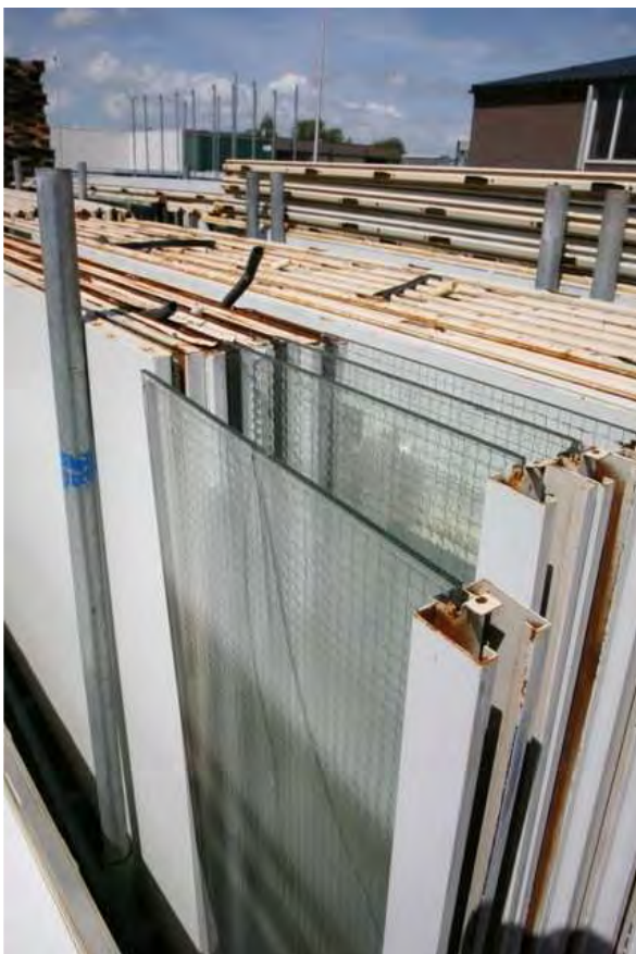
Gedemonteerde verplaatsbare wanden
