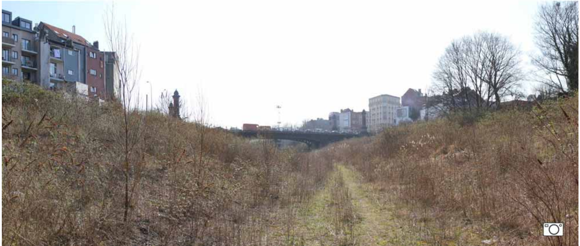
L28 A / PONT DU JUBILE - JUBELFEESTBRUG
