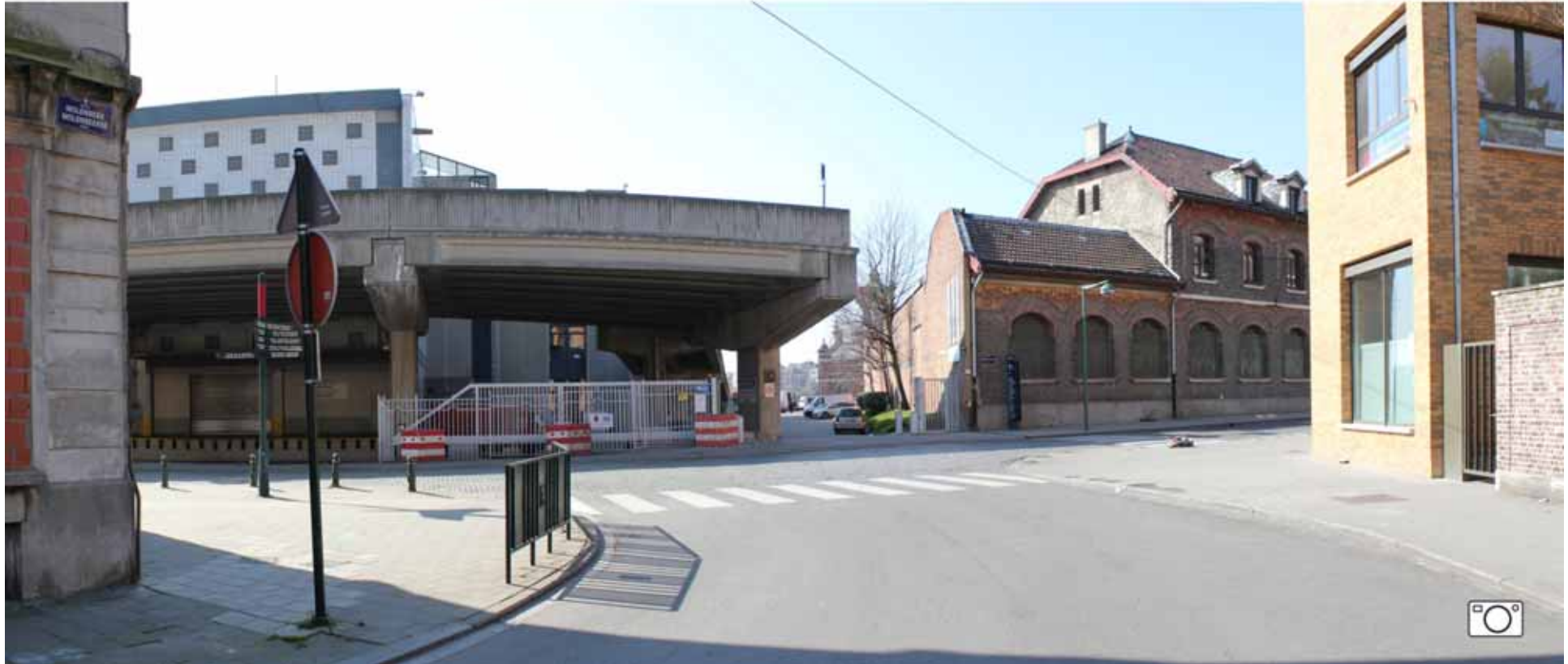
RUE DIEUDONNE LEFÈVRE STRAAT / RUE MOLENBEEK STRAAT
