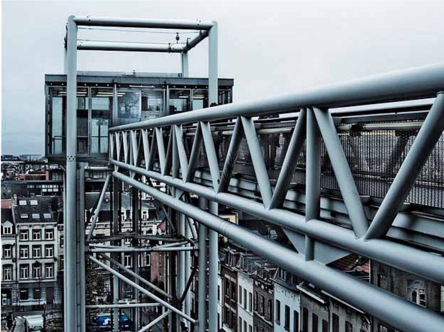
ACCESSIBILITE PMR: ASCENSEUR DE MAROLLES / BEREIKBAARHEID VOOR ANDERSVALIDEN: LIFT MAROLLEN
