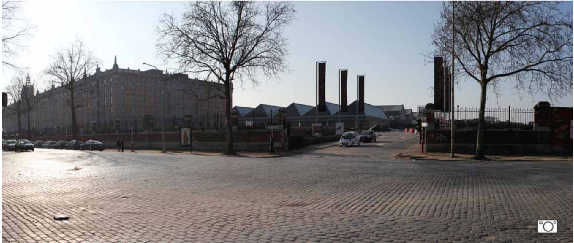
AVENUE DU PORT / HAVENLAAN
