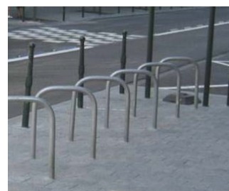
Arceaux installés par la Région de Bruxelles-Capitale
