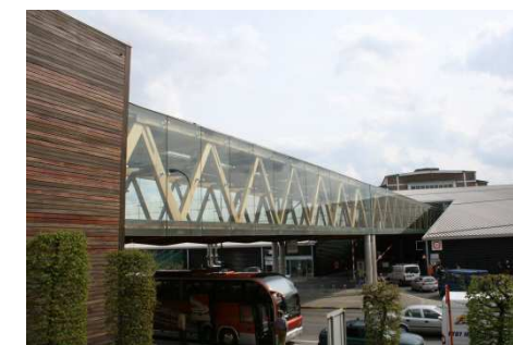
Passerelle du Parc des expositions
