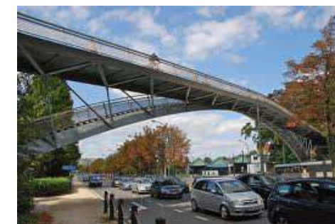
Passerelle avenue de Tervuren à 1150 Bruxelles
