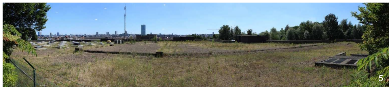
Toiture bâtiment STIB
