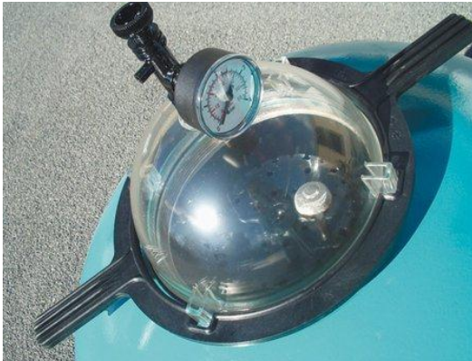
Figure 7.25 Manomètre à l'entrée d'un filtre à sable
