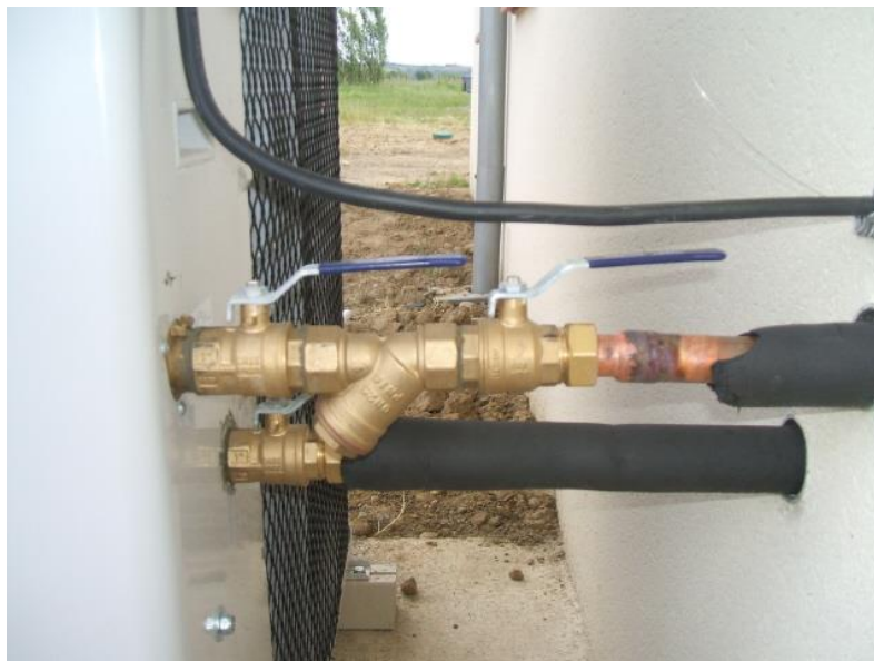
Figuur 2.15 Voorbeeld van isolatie, af te werken op de kleppen van een omkeerbare warmtepomp.
