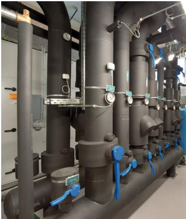
Figuur 2.8 ijswatercollector – vertrek- en retourleidingen met thermowells en temperatuurvoelers
