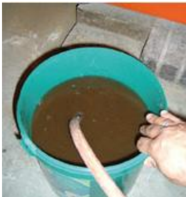
Figuur 2.23 Afzetting controleren bij het ledigen van een slibafscheider
