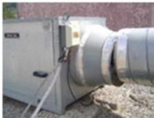
Figuur 2.1 voorbeeld van beschadigde luchtkanalen (uitgang pulsiegroep)
