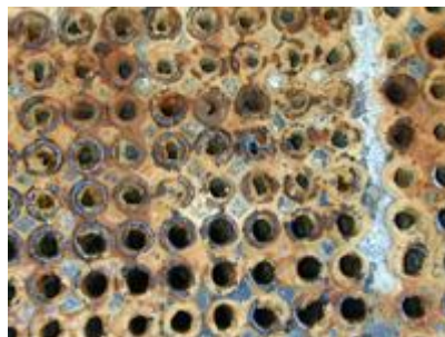
Figuur 1.2 Voorbeeld van te verbeteren onderhoud: vuile warmtewisselaar (verkalking en corrosie)
