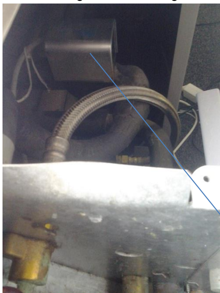
Figuren 2.20 tweewegklep op een ijswatercircuit van een ventilo-convector en de bedieningselement : de thermostaat
