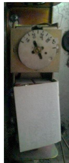
Figuren 2.20 tweewegklep op een ijswatercircuit van een ventilo-convector en de bedieningselement : de thermostaat
