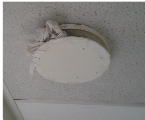
Figuur 2.15 : probleem met de verdeling van het luchtdebiet
