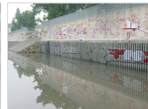
Opslag van het regenwater
