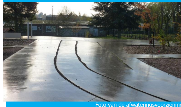
Foto van de afwateringsvoorziening
