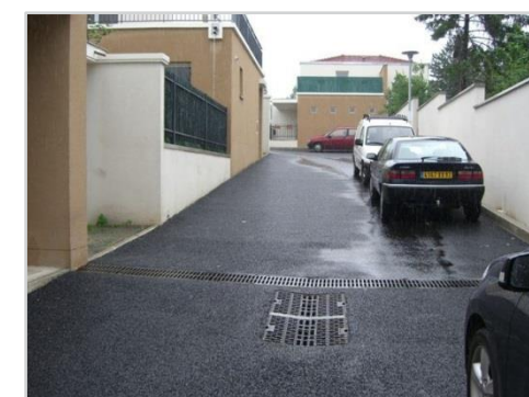
Stroomafwaarts van de weg gelegen geul
