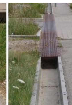
Inrichtingen voor de verzameling en het vervoer van regenwater in de open lucht
