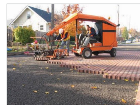
Aanbrenging van doorlatende bestrating als bovenlaag van de weg
