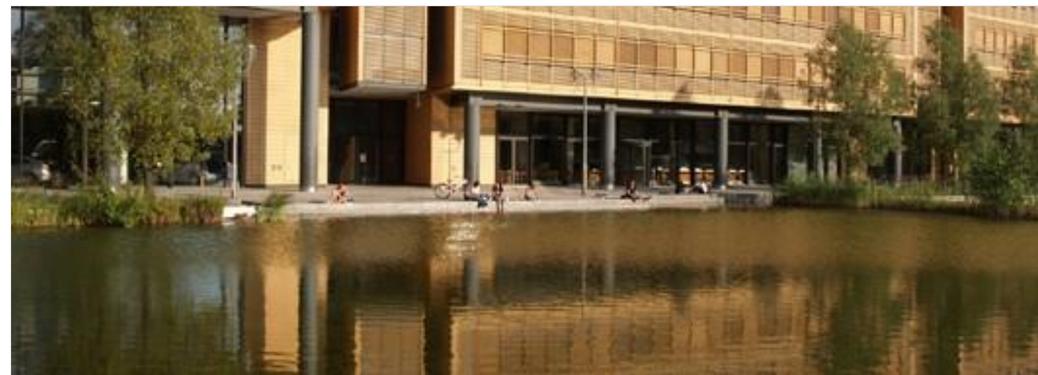
Bekken met filtering door een zandfilter en planten
