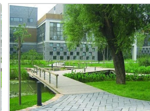
Foto's van de infiltratieoppervlakken
