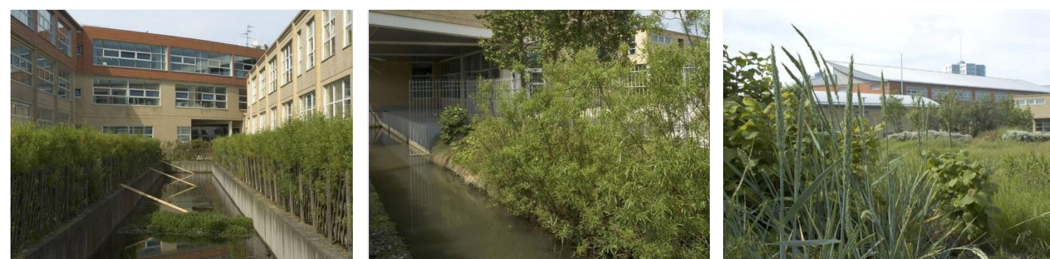
Opslagbekken voor regenwater, voor behandeling en hergebruik
