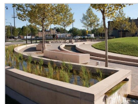
Filtering van het water door 'moerasplanten'
