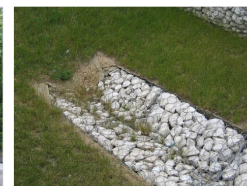
Detailfoto van de drainagemat
