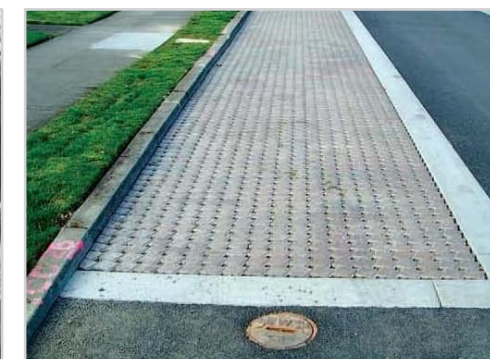
Geperforeerde vlakken ter controle van de infiltratiesnelheid
