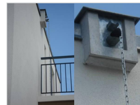
Waterspuwer voorzien van een regenketting
