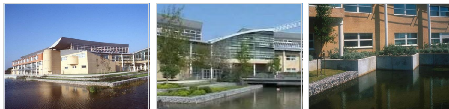
Opvangbekken voor regenwater bij buitengewone regenval
