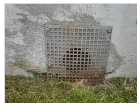
Verbinding tussen het bekken en de filter
