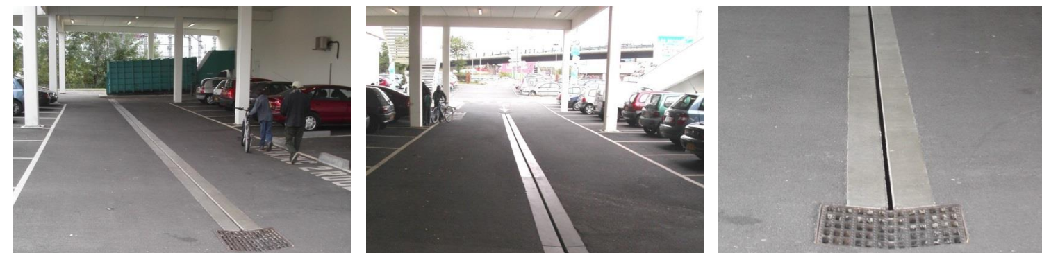
Inrichtingen voor de verzameling en het vervoer van regenwater in de open lucht
