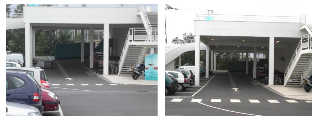
Overlopen ingewerkt in de trappen
