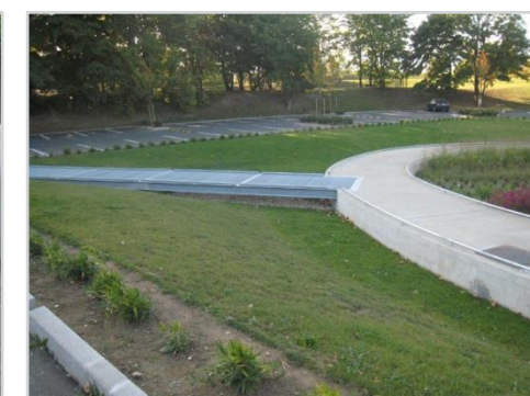
Wateropeningen in de boordstenen
