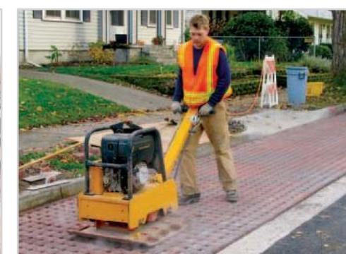
De bestrating werd verdicht en de voegen werden opgevuld met zand
