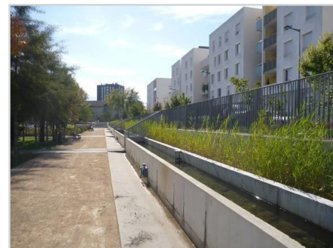
Behandelingskanalen via filtering met behulp van aangeplant riet
