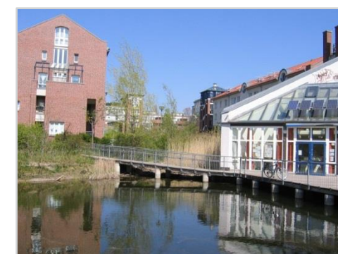
Aankomst van het water in de vijver
