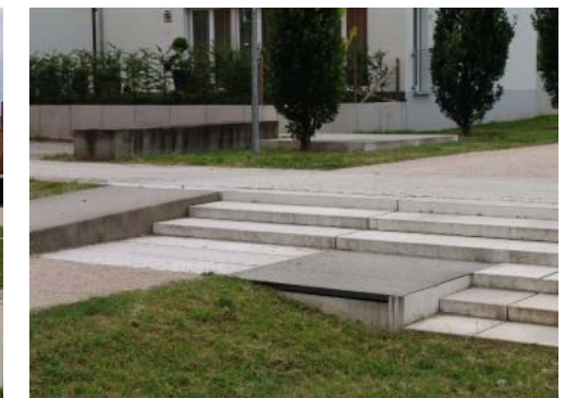
Overlopen ingewerkt in de trappen
