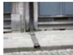
Les gouttières descendent des toitures et acheminent l'eau jusqu'à la rue où elle s'écoulera dans les bouches d'égouts.
