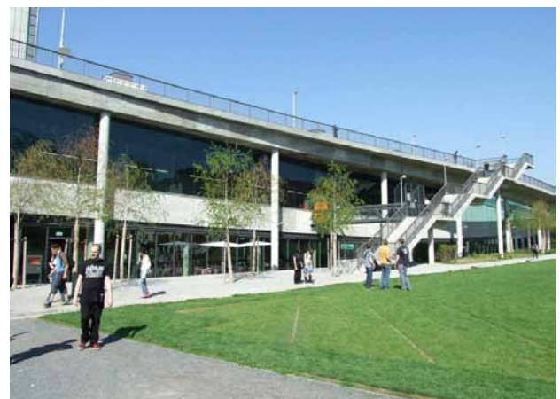
Stedelijk park langs een grote weginfrastructuur Basel, Zwitserland
