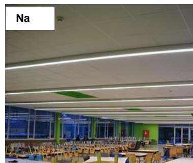
foto 4 : Foto's van de eetzaal vóór de werken, met de voorgestelde oplossing (geel absorberend plafond) en na de werken (Bron: Leefmilieu Brussel, Fiche 34. Blootstelling aan geluidsoverlast in de scholen, 2012, 11 p.).
