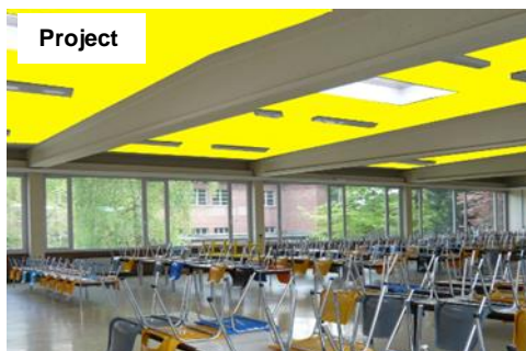
foto 4 : Foto's van de eetzaal vóór de werken, met de voorgestelde oplossing (geel absorberend plafond) en na de werken (Bron: Leefmilieu Brussel, Fiche 34. Blootstelling aan geluidsoverlast in de scholen, 2012, 11 p.).
