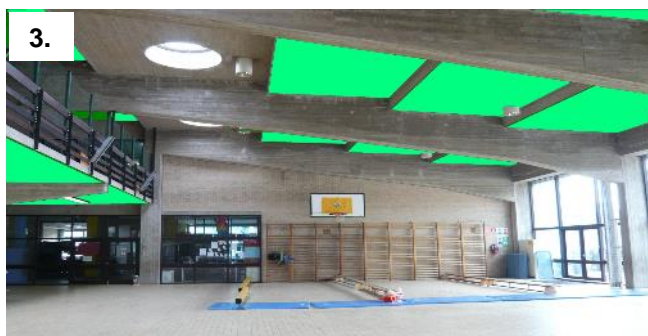
foto 3 : De oplossingen die Leefmilieu Brussel voorstelt om de nagalmproblemen te verminderen (1. binnenspeelplaatsen, 2. en 3. sportzalen, 4. eetzaalen) berusten doorgaans op de plaatsing van absorberende panelen tegen plafonds en muren. (Bron: Leefmilieu Brussel, Fiche 34. Blootstelling aan geluidsoverlast in de scholen, 2012, 11 p.).
