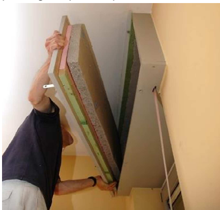
Figure 47 : Mise en œuvre
