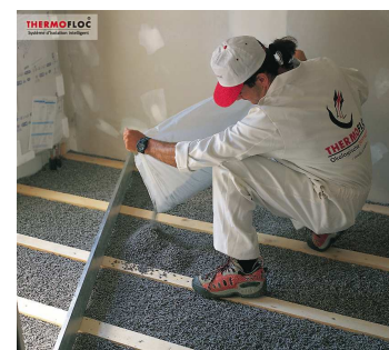
Figure 27 : Mise en œuvre (© Thermofloc)
