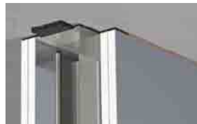
Figure 33 : Raccord plafond (© Gyproc)
