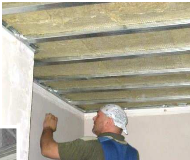
Figure 31 : Mise en œuvre (© Renov PM)
