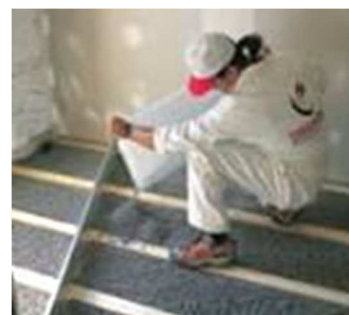
Figuur 27 : Aanbrengen (© Thermofloc)
