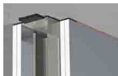
Figuur 33 : Plafond aansluiting (© Gyproc)
