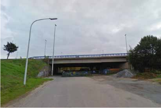
4. tunnel existant (côté nord)
