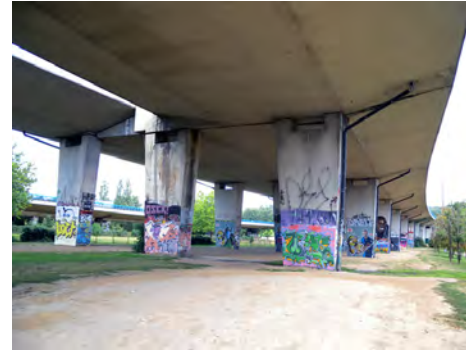
↑ Le passage du Ring au-dessus du parc des Étangs à Anderlecht
