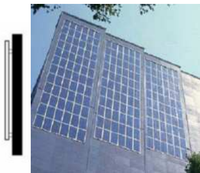
Figuur 8: Voorbeeld van een verticale plaatsing van panelen (Hespul)
