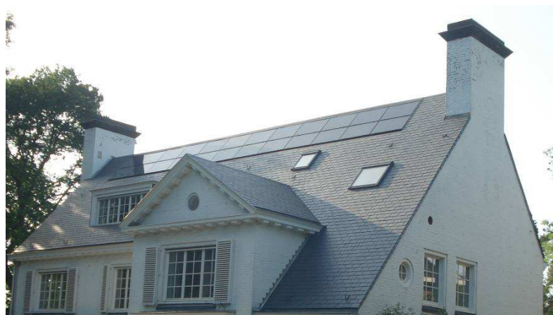
Figuur 7: Voorbeeld van een FV-paneel geïntegreerd in een leien dak (Hespul - APERe)
