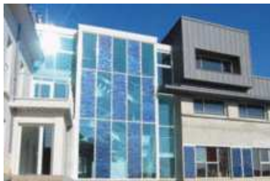
Figuur 9: Voorbeeld van een integratie in de gevel (Hespul)
