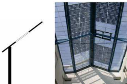
Figuur 11: Voorbeeld van een geïntegreerde glazen kap (Hespul)
