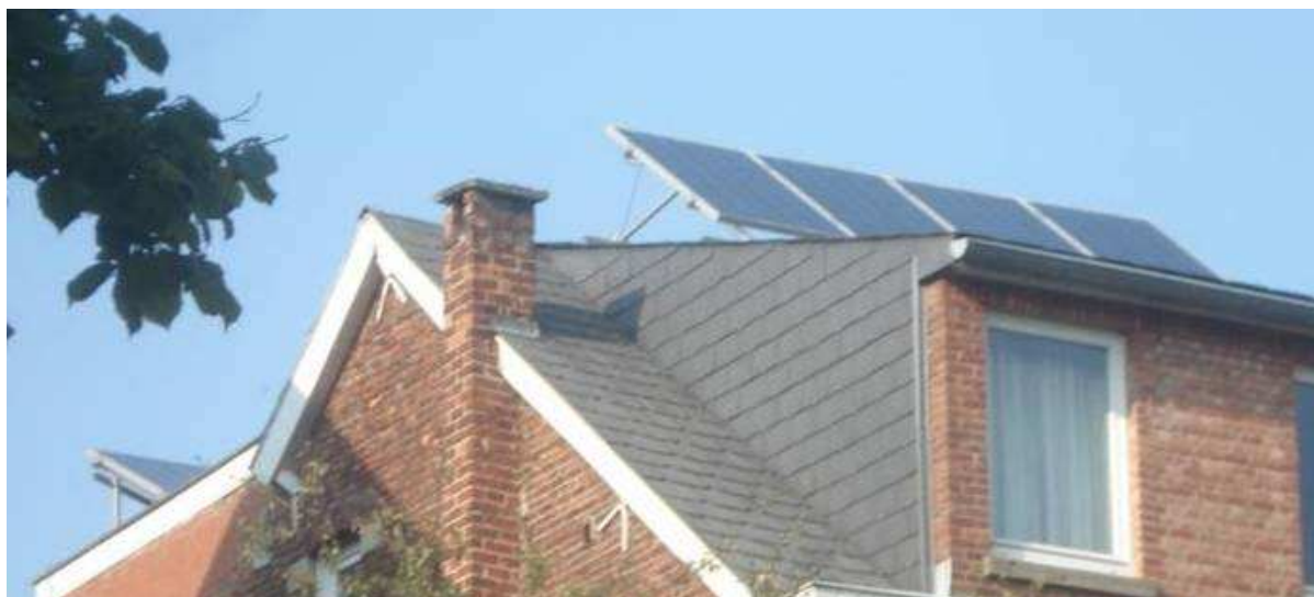
Figuur 17: een vergunning is noodzakelijk, want de panelen staan niet parallel aan het dak en zijn zichtbaar vanaf de straat
