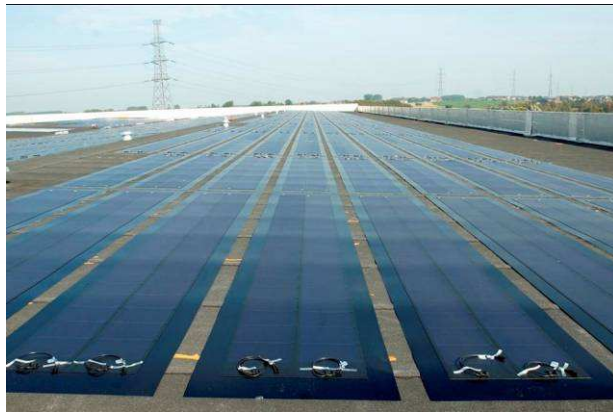
Figuur 5: Systeem met soepele amorfe siliciumpanelen die zijn gekleefd op het waterdichte membraan van de dakbedekking, Project Colruyt, Halle. [Hespul – Foto Colruyt]
