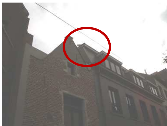
Figuur 18: een randgeval waarbij de panelen amper zichtbaar zijn vanaf de straat
