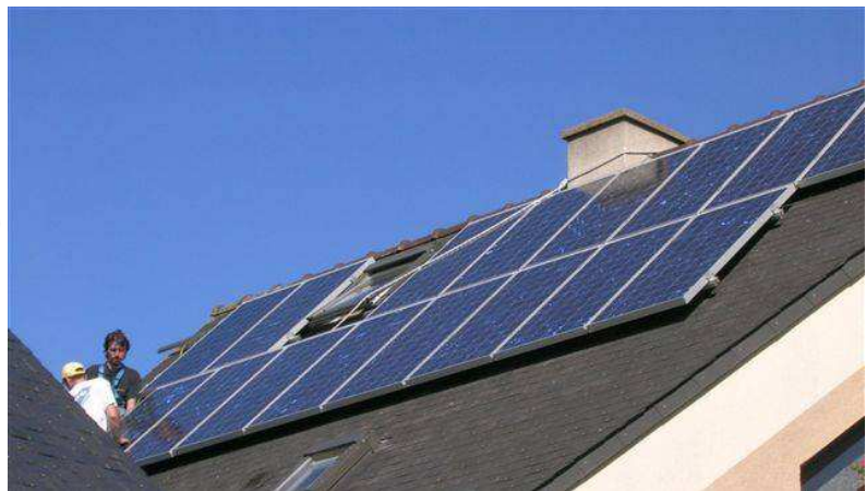
Figuur 6: Voorbeeld van een FV-paneel in opbouw op een leien dak (Hespul - 3E)
