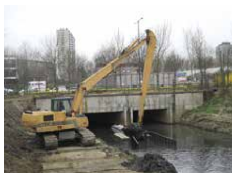
Ruimingswerken in de Zenne.
