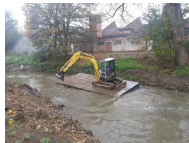
Figuur 22: Ruimen van slib in de Zenne en inrichting van haar omgeving
