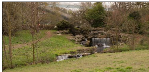
Figuur 18: Waterlopen van Woluwe, Woluwepark
