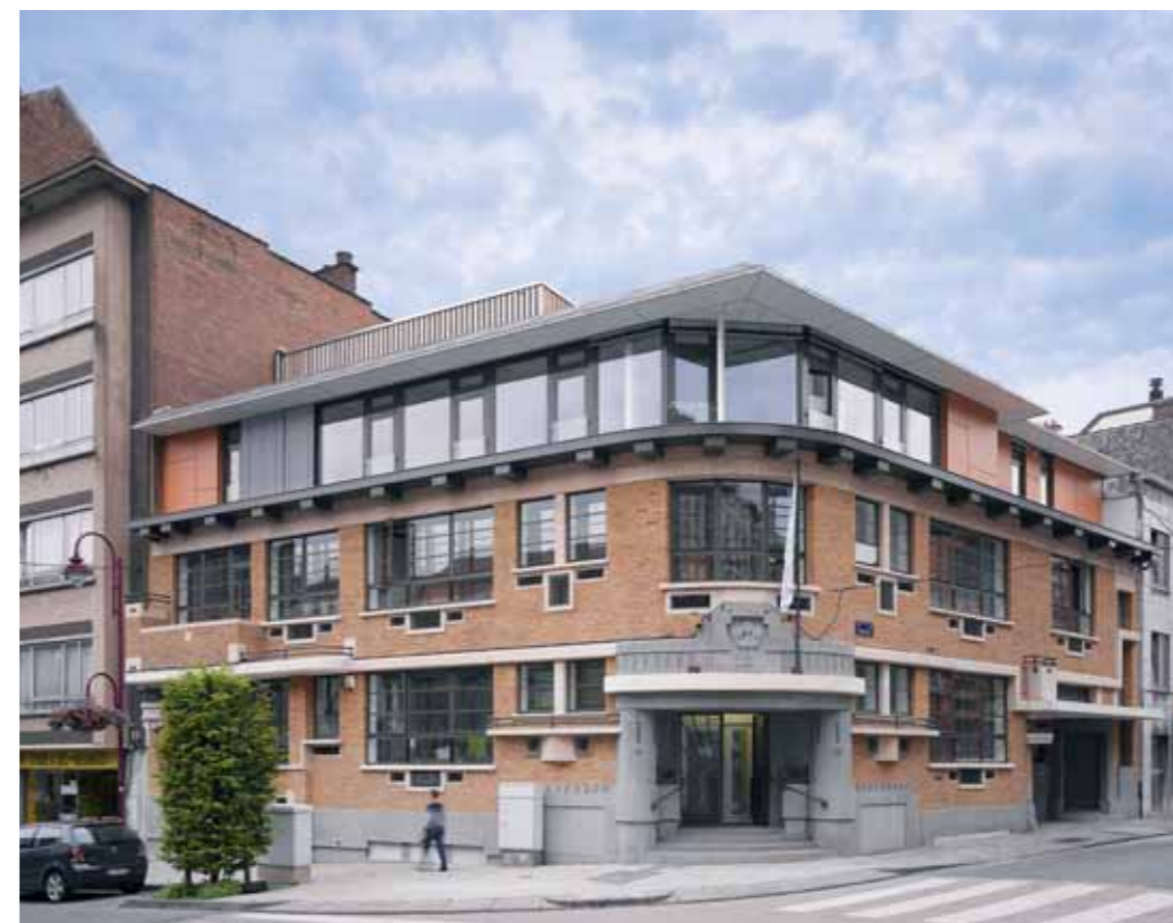
Passiefrenovatie van kantoren in de Nysstraat [009]: deze passiefkantoren zijn het resultaat van de herbestemming van een oud biologie-laboratorium van 650 m 2 . Het kubische volume van de verdieping werd omhuld met een isolatie van 24 centimeter en afgewerkt met een pleisterlaag. De benedenverdieping wordt ingenomen door drie lage-energie woningen (Architects Office Lahon & Partners).
