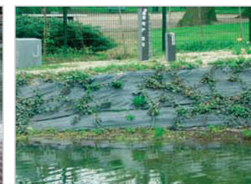
Bassin de rétention
