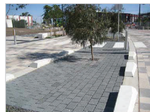
La bande centrale poreuse
