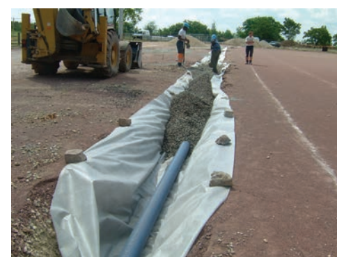
Réalisation du drain
