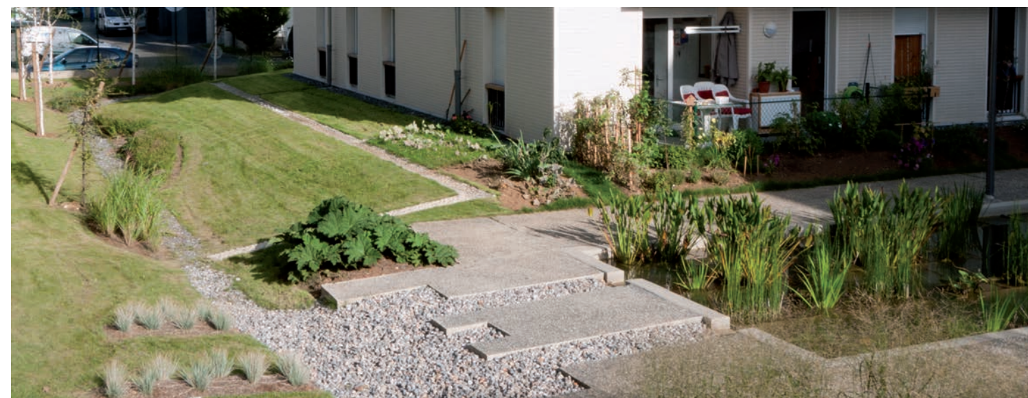
Déversoir du bassin vers l'espace vert
