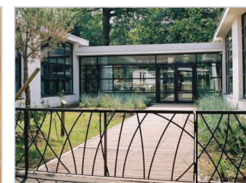
Les aménagements paysagers aux abords du bassin de rétention
