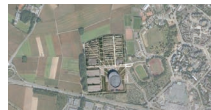
Allée du Zénith
