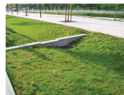
Détails de la noue, le long du parvis
