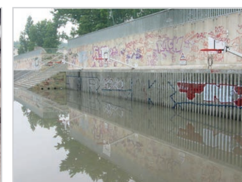
Stockage des eaux pluviales
