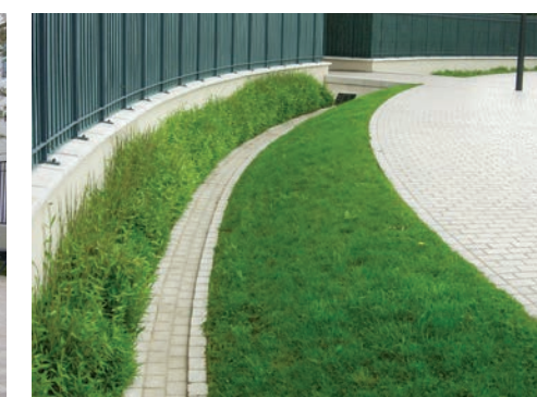
Dispositif d'ajutage entre les deux noues
