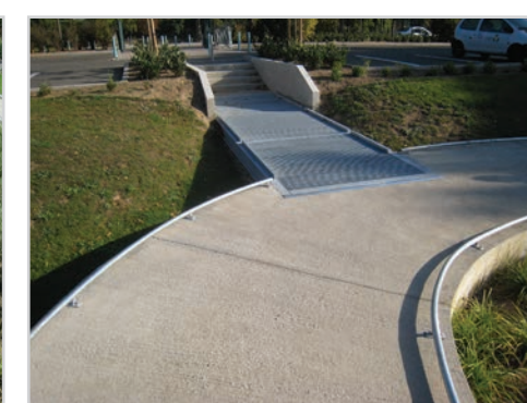
Cheminement piéton sur l'ouvrage
