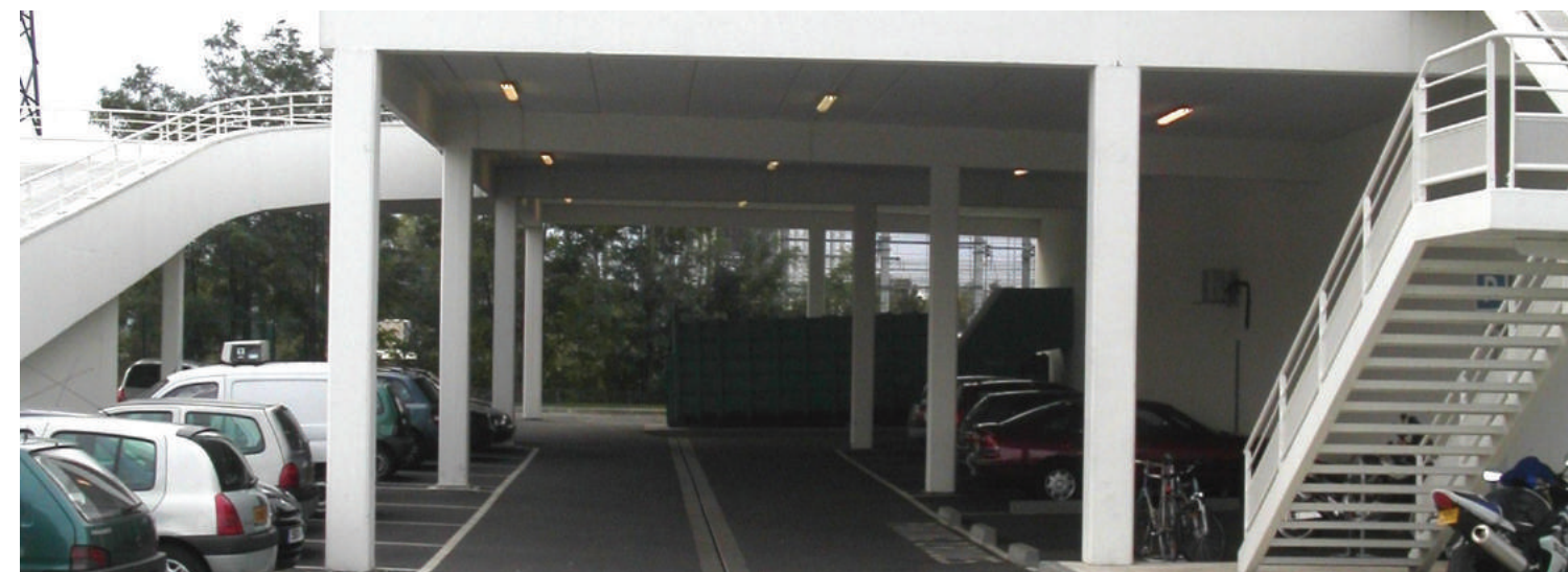
Parc de stationnement intégrant les dispositifs de stockage enterrés
