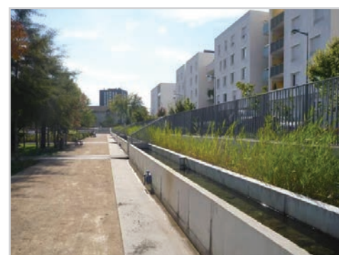
Canaux de traitement par filtre planté de roseaux
