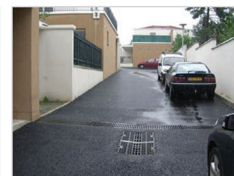
Caniveau en aval de la chaussée
