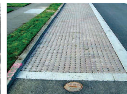
Conduites perforées servant de puits pour contrôler les taux d'infiltration
