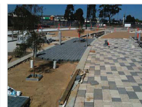
Filtres à sable visibles pendant les travaux
