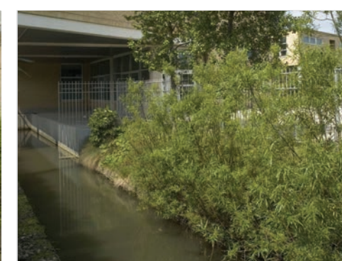
Bassin de stockage des eaux pluviales, pour traitement et réutilisation
