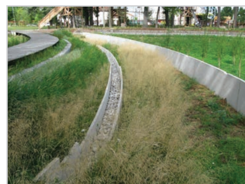
Zone de surverse des eaux pluviales
