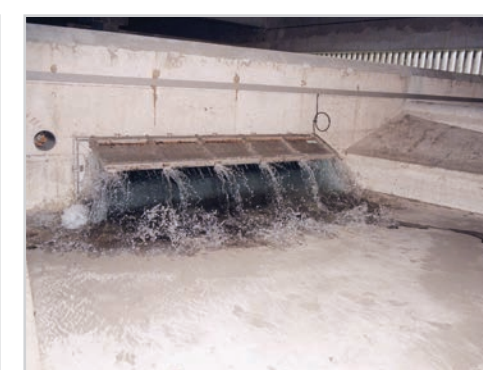
Remplissage du pré-bassin
