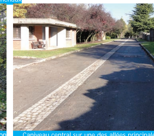
Caniveau central sur une des allées principales
