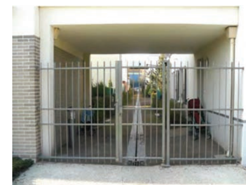
Arrivée des eaux pluviales des surfaces privées
