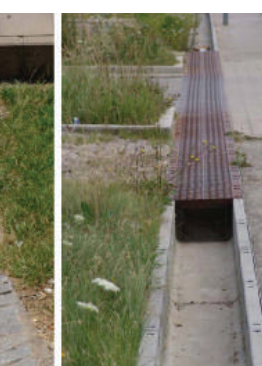
Dispositifs de collecte et transport des eaux pluviales à ciel ouvert
