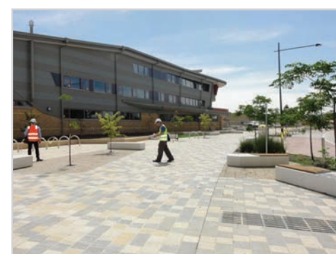
La bande centrale poreuse
