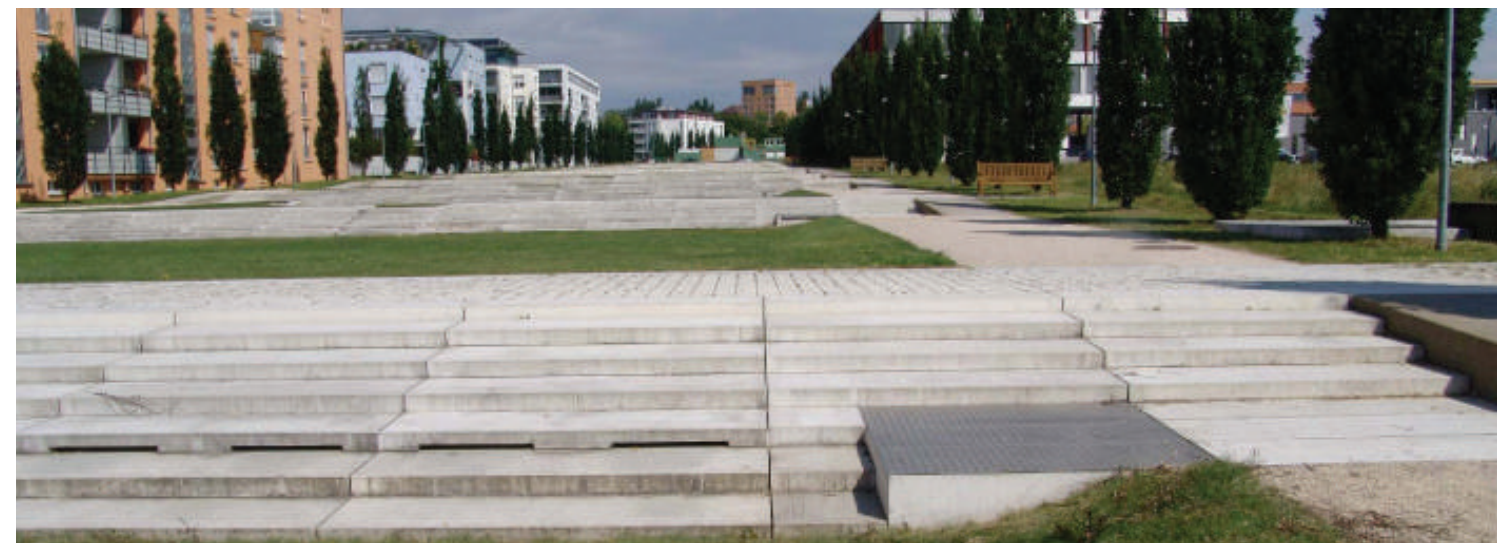
Parc intégrant les dispositifs de stockage enterrés
