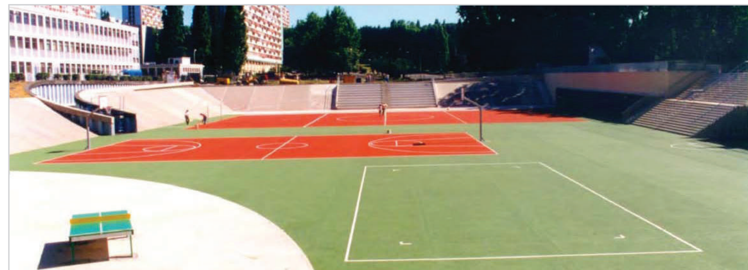
Vue générale du dispositif
