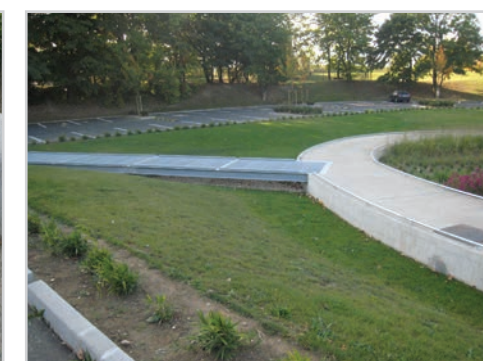
Cheminement de l'eau entre les bordures
