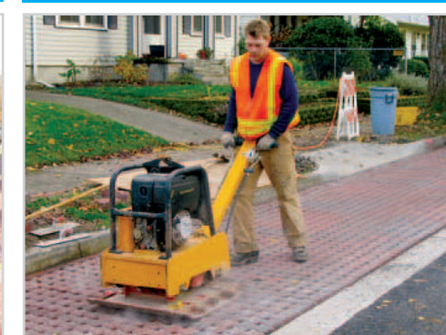
Les pavés ont été compactés et les joints remplis de sable
