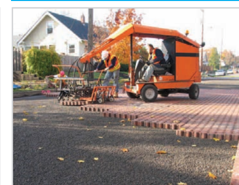
Placement des pavés perméables formant la couche supérieure de la voirie
