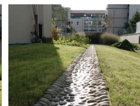
Cheminement de l'eau à ciel ouvert
