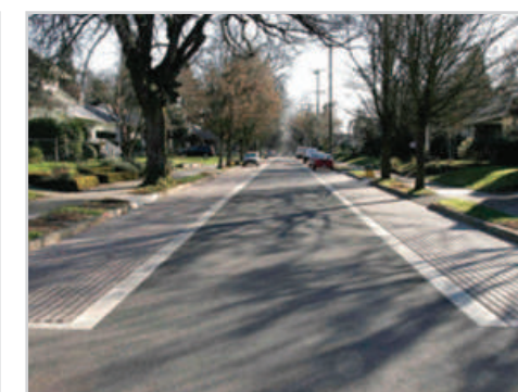
Chaussées perméables de part et d'autre de la 21 th avenue à Westmoreland
