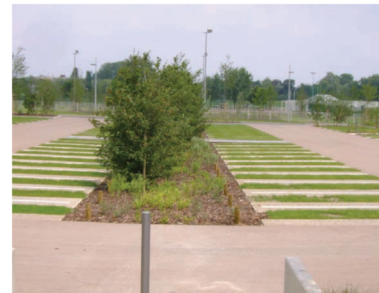
Vues des noues d'infiltration et des tranchées d'infiltration
