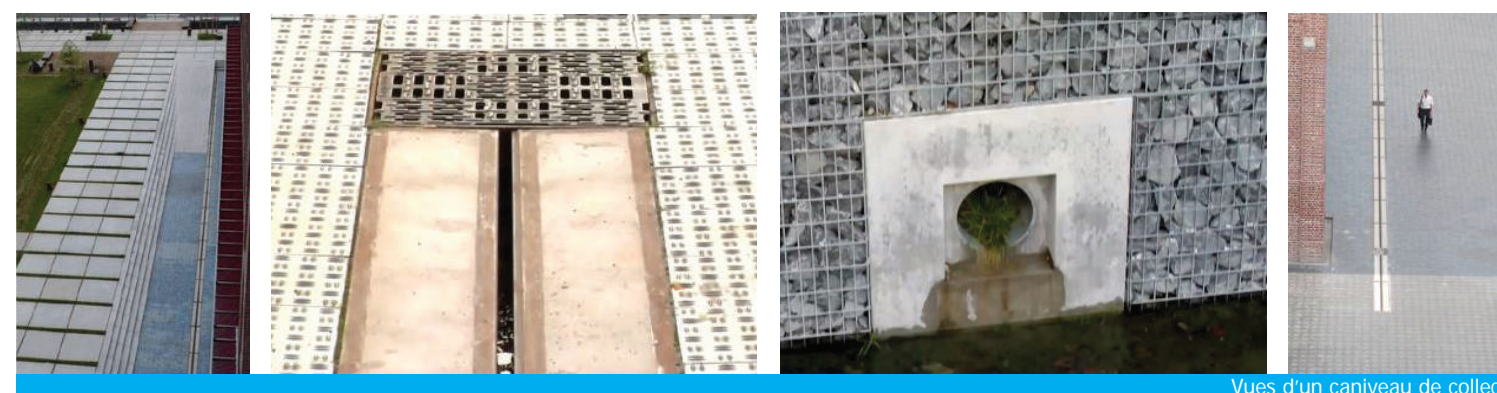
Vues d'un caniveau de collecte
