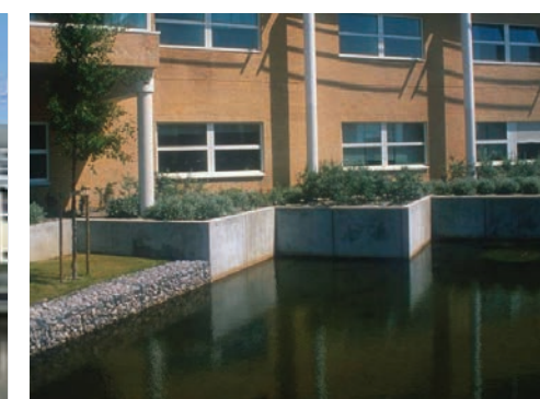
Bassin de rétention des eaux pluviales en cas de pluie exceptionnelle
