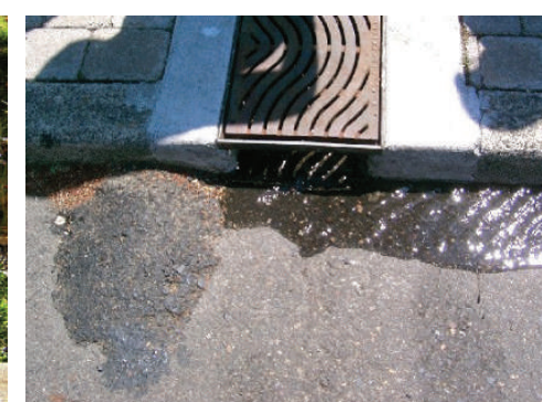
Élévation de la voirie après la bouche avaloir
