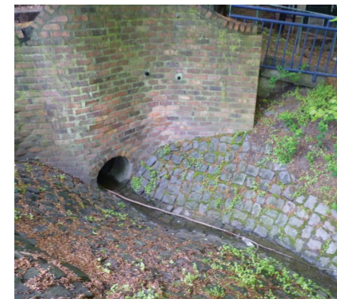
Vues générales du fossé
