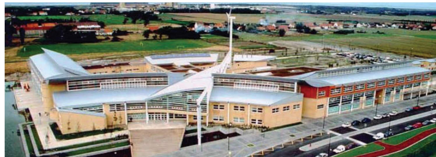
Vue générale du lycée
