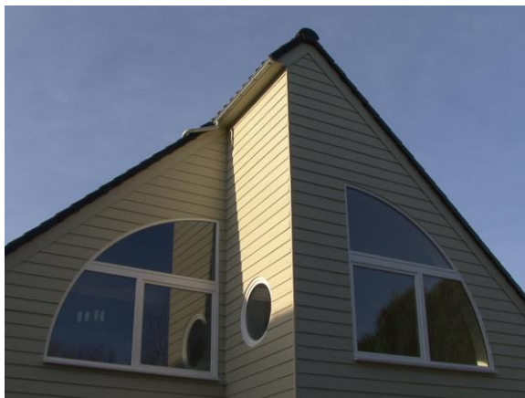
Ajout d'un étage sur une maison à Wezembeek
