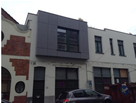
Reconstruction d'un étage passif batex sur un bâtiment existant à Etterbeek
