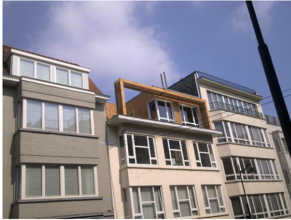
Rajout d'un étage sur un petit immeuble à Uccle
