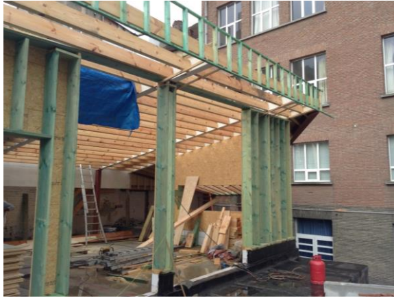
Construction de nouvelles classes à l'intérieur d'une cour d'école sans accès à Etterbeek
