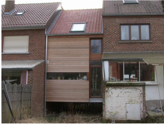
Maison construite entre mitoyens sans fondations
