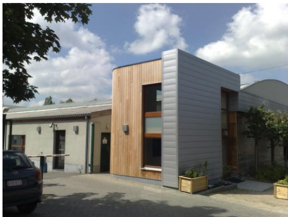
Extension à Zaventem pour loger un centre d'accueil pour une société de taxis
