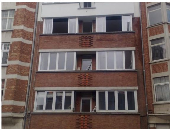
Pose de trois nouveaux étage sur un immeuble à Etterbeek
