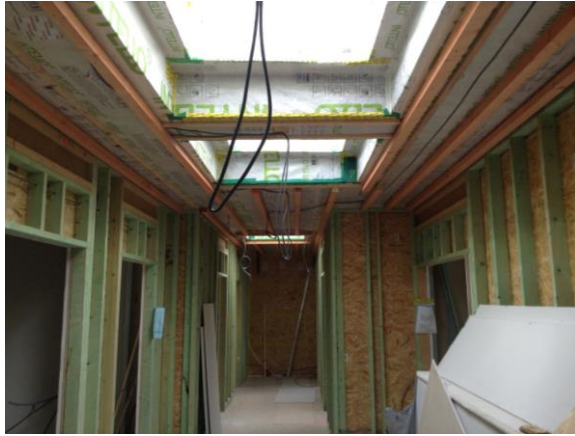
Chantier vu de l'intérieur
