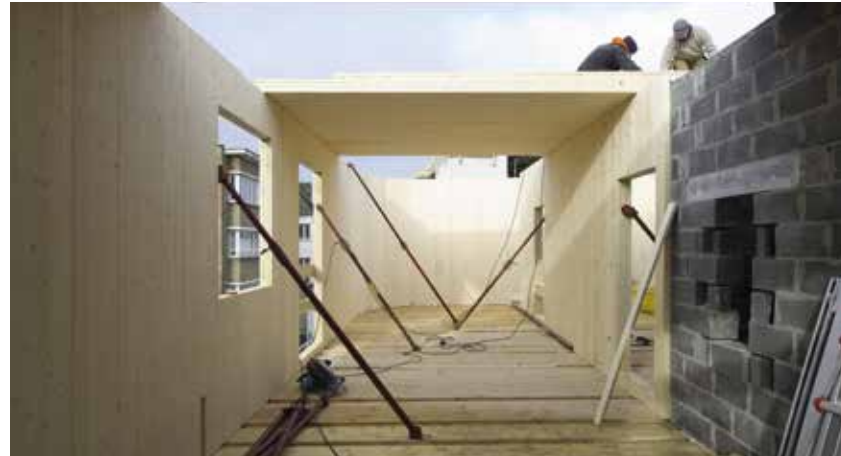
[238] Zinneke-terrein Een structuur in gelamineerde massieve houten panelen, volledig in prefabricatie.
