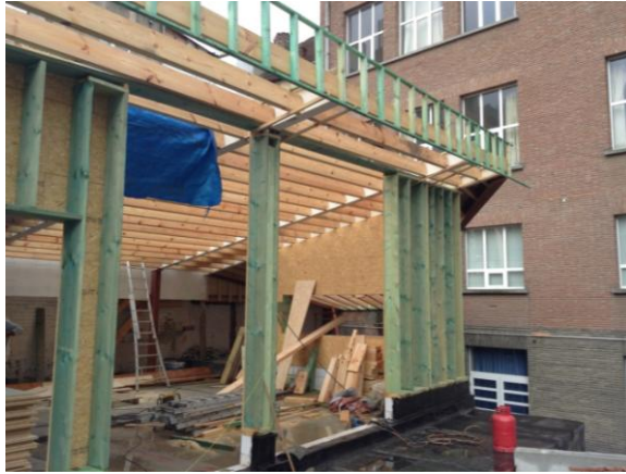
Bouw van nieuwe klassen op de binnenplaats van een school waar geen toegang was te Etterbeek
