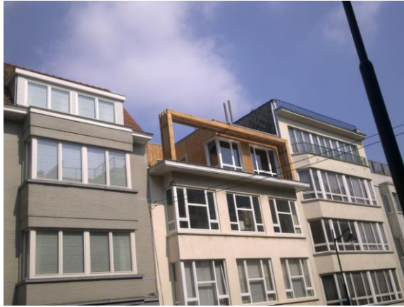
Toevoegen van een verdieping aan een klein gebouw te Ukkel
