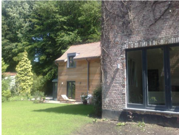
Uitbreiding te Ukkel aan de achterkant van een herenhuis als woning voor de mama
