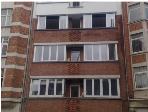
Drie nieuwe verdiepingen in een gebouw te Etterbeek
