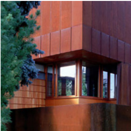
CORTEN – TERRAS, HOUTEN RAAMWERK
