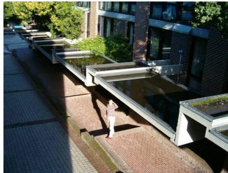
Dak als opslag in Louvain-la-Neuve - foto : Valérie MAHAUT
