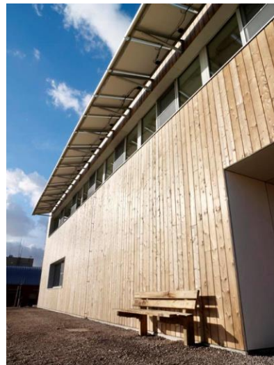
gevelbekleding van duurzaam veredeld hout
