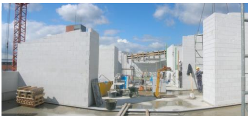
ruwbouw uit superisolerende cellenbeton-blokken.
