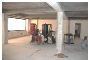
Asbestverwijdering
