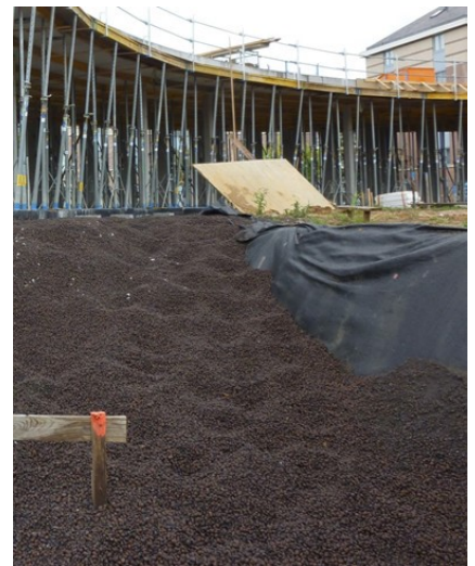
Plaatsen van geëxpandeerde kleikorrels op de werf van Voorbeeldgebouwen "Trèfles" - architectenbureau ARTER
