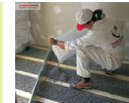
Figure 27 : Mise en œuvre (© Thermofloc)
