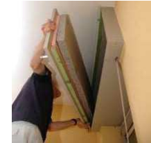
Figure 47 : Mise en œuvre
