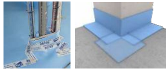
Figuur 21 : Extra scheidingsstuk plaatsen voor de uitgaande hoeken
