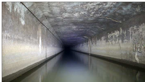
Photo de l'intérieur du pertuis
