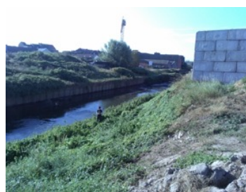
Remblais (rive gauche S1)
