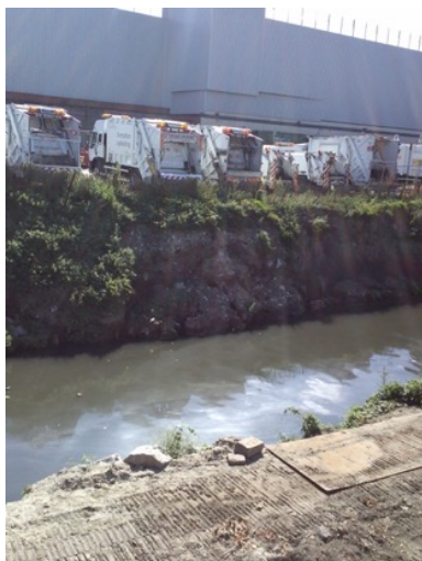
Remblai (Rive droite – S5)
