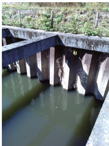
Palplanche (Rive gauche – S3)
