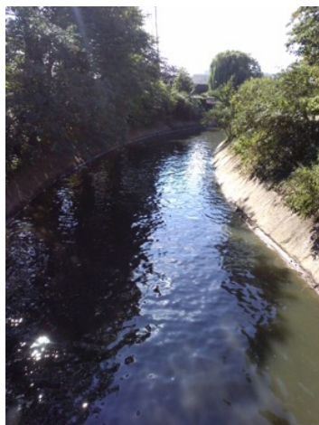
Béton (Rive gauche – S5)
