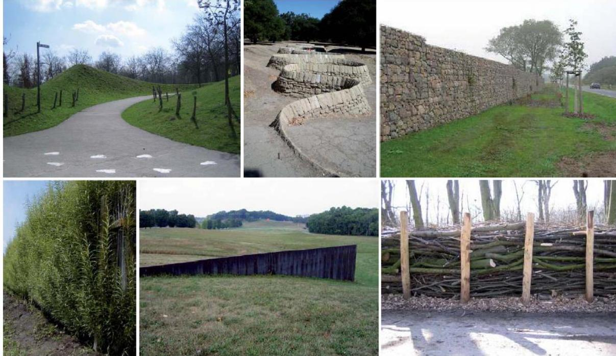
La performance acoustique d'un **mur anti-bruit** (en matériaux naturels ou artificiels) est déterminée par son emplacement, sa longueur et sa hauteur ainsi que par ses caractéristiques de transmission et de réflexion/absorption. Cacher la source a un effet psychologique sur la perception du bruit mais il faut néanmoins être attentif à ne pas obstruer les vues intéressantes depuis ou vers l'espace vert. Un choix judicieux de matériaux évitera également les réflexions vers les zones en vis-à-vis.
