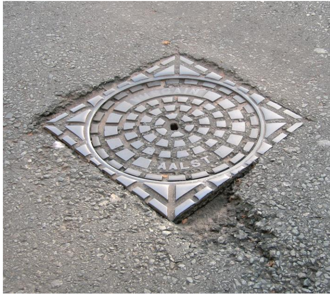
Figuur 47 - megatextuur door een slecht ingewerkt putdeksel met een ongunstige textuur
