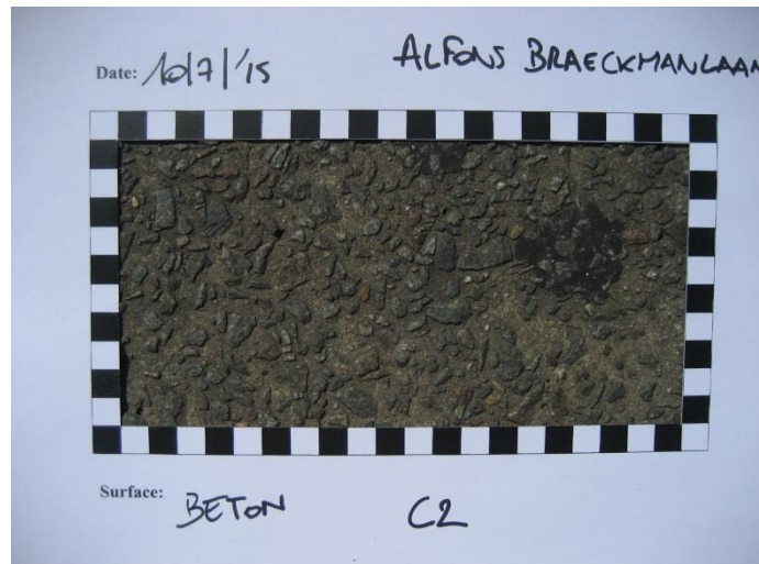
Figuur 21 - Alfons Braeckmanlaan, Gent (beton, C2)
