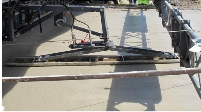
Figuur 35 - een "supersmoother" maakt transversale ook draaiende bewegingen om oneffenheden te vermijden.
