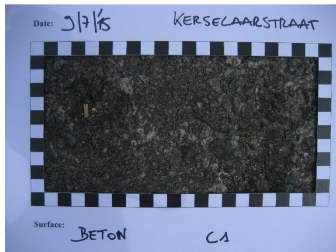
Figuur 20 - Kerselaarstraat, Gent (beton, C1)
