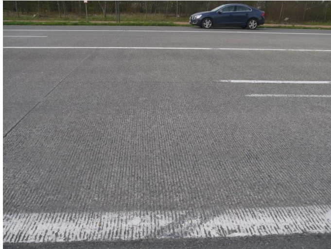
Figuur 40 - een transversaal gegroefd beton wegdek.
