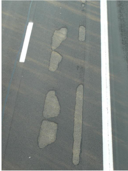
Figuur 75 - loskomen van een dunne deklaag van de onderlaag (ook delaminatie of scholvorming genoemd).
