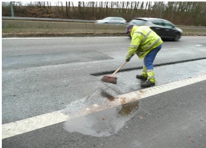
Figuur 80 – schoonmaken en drogen.
