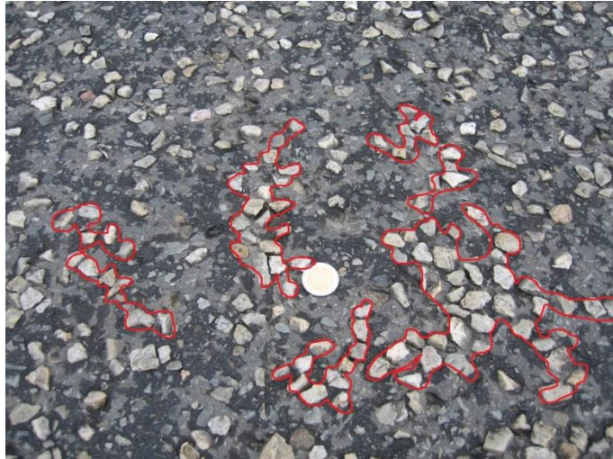
Figuur 37 - megatextuur door niet homogene macrottextuur: niet homogene spreiding van aggregaat op een begrind asfaltwegdek.
