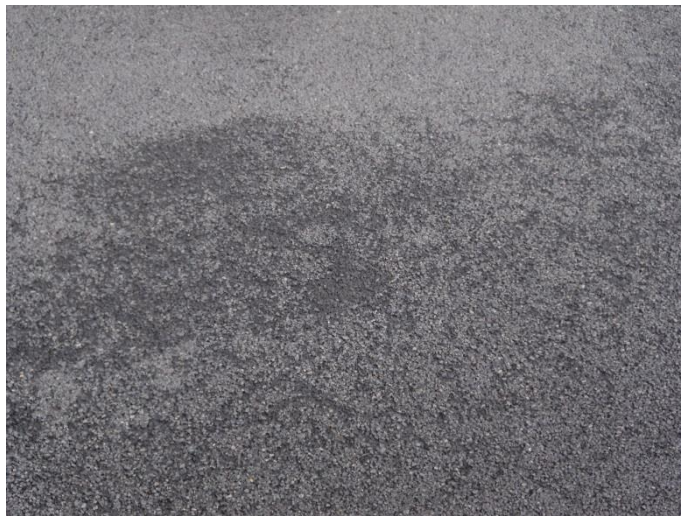
Figuur 74 - rafeling van een dunne deklaag.
