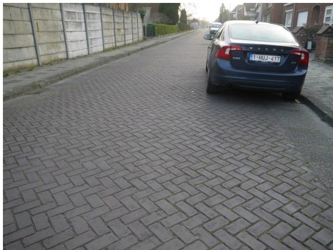
Figuur 42 - straatstenen in keperverband.
