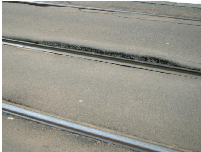
Figuur 49 - slecht ingewerkt tramspoor.
