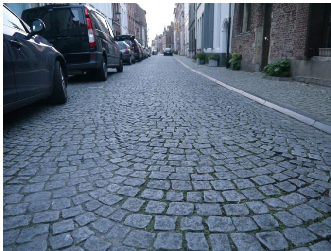
Figuur 38 - intrinsieke megatextuur bij een wegdek in kasseien.
