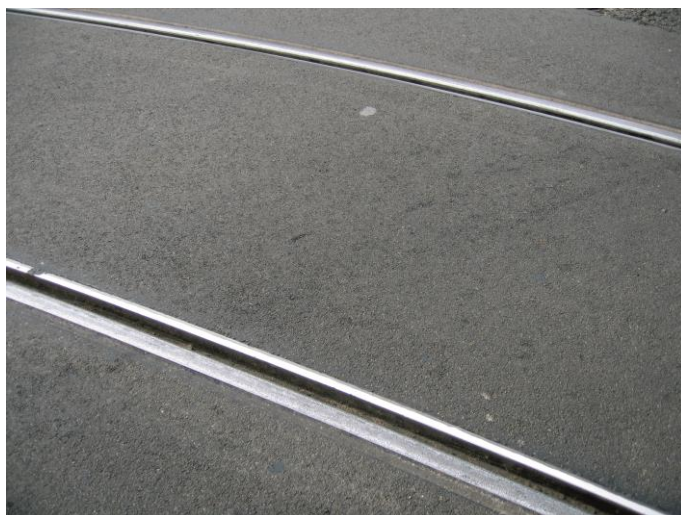
Figuur 50 - goed ingewerkt tramspoor met rubber dichting.
