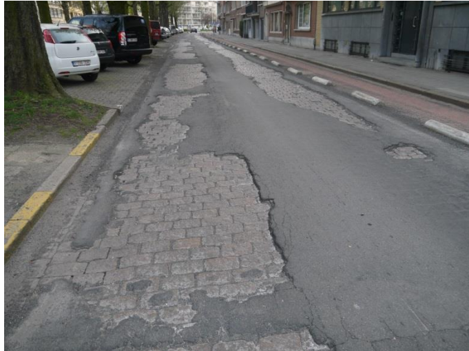
Figuur 78 - overlaging van kasseien met een laag asfalt.
