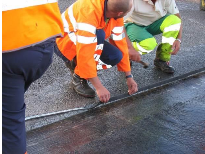
Figuur 82 – voegband aanbrengen.
