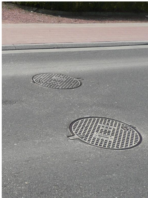
Figuur 48 - putdeksel met fijne textuur zonder onvlakheid.
